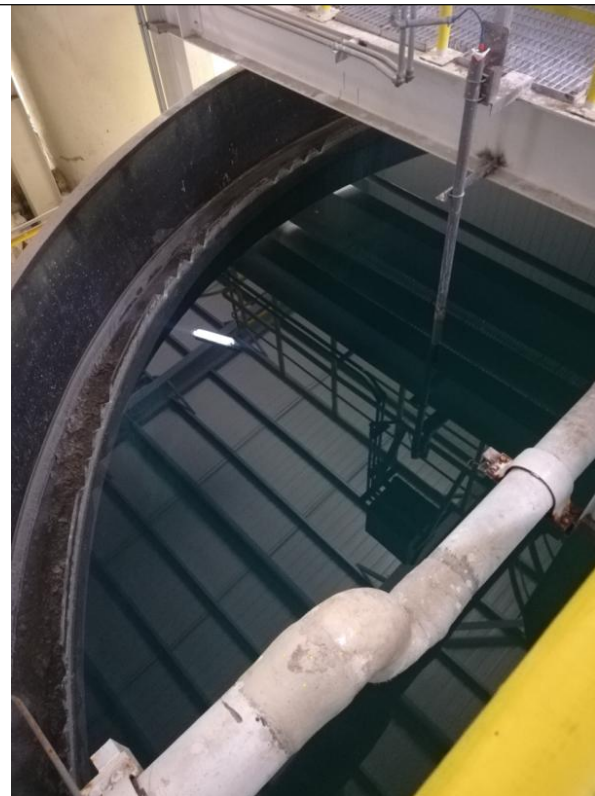
低氯废水处理装置顶部
