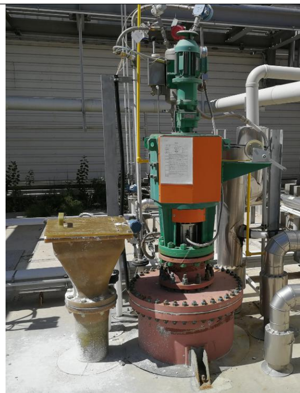
超纯硅车间酸性废水中和加料泵
