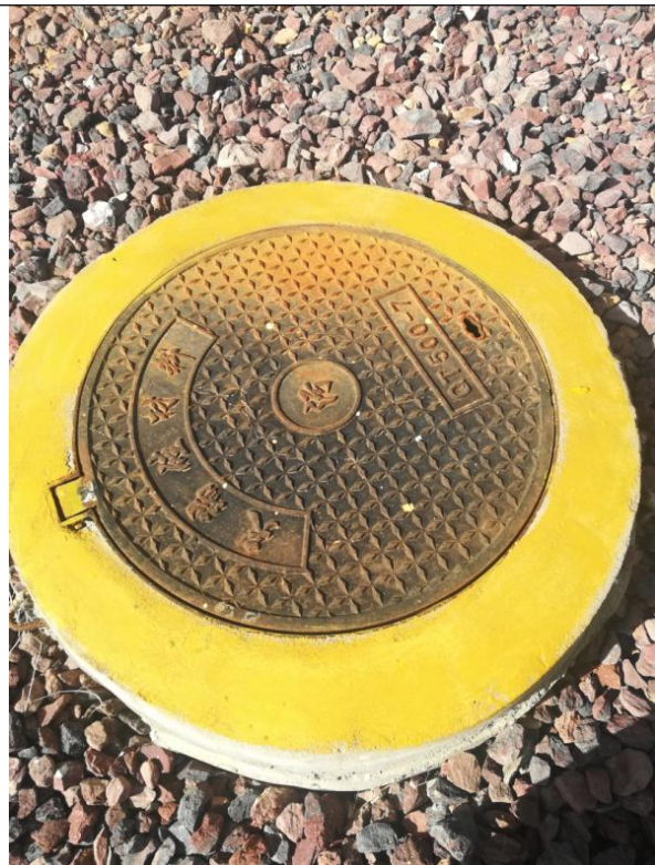
生产区生活污水化粪池
