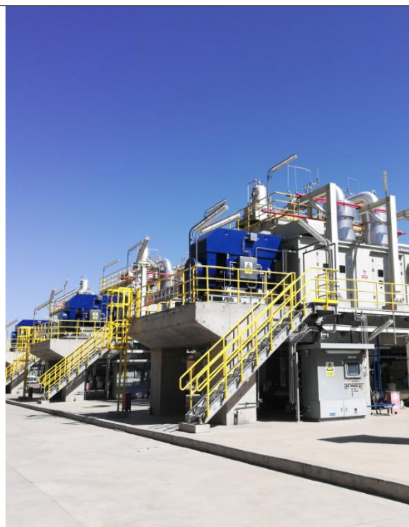
基础减震+隔声
