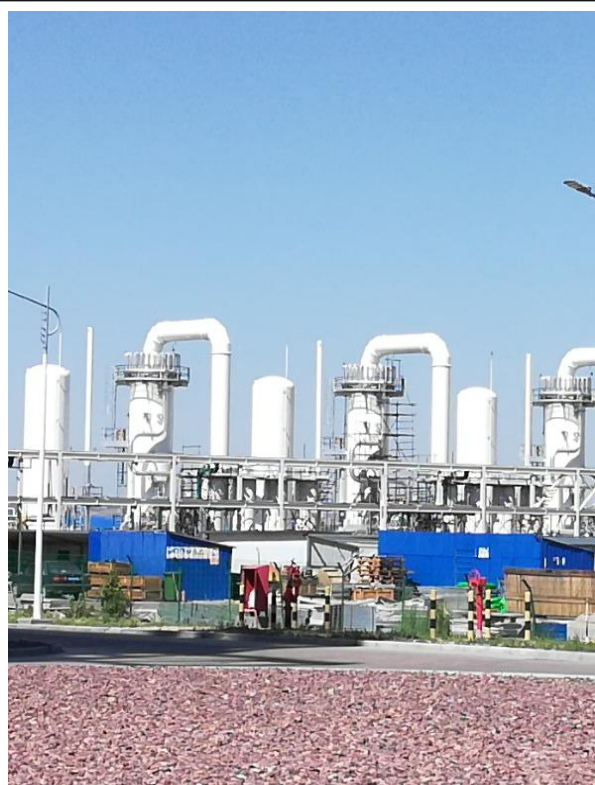
制氢装置区排气筒（3个排气筒）
