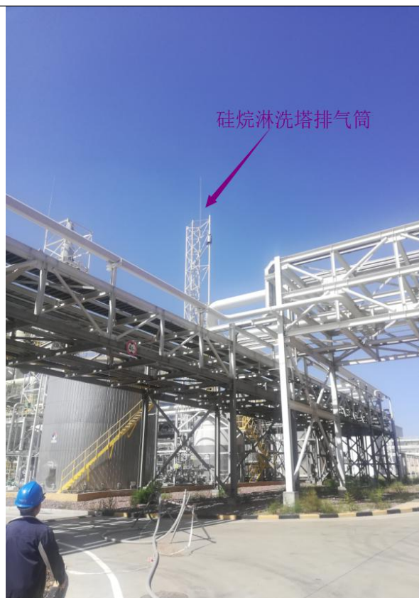
工艺废气处理区硅烷淋洗塔排气筒
