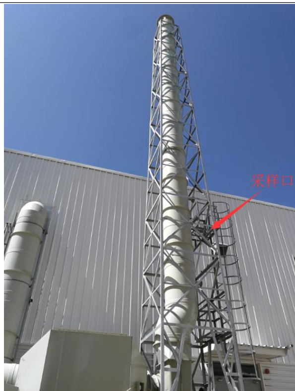
质量部实验室工艺废气吸收装置排气筒
