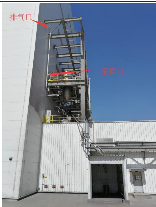
FBR（流化床）包装工段排气筒
