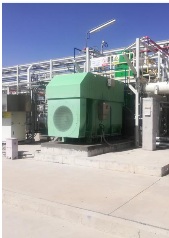
基础减震+隔声
