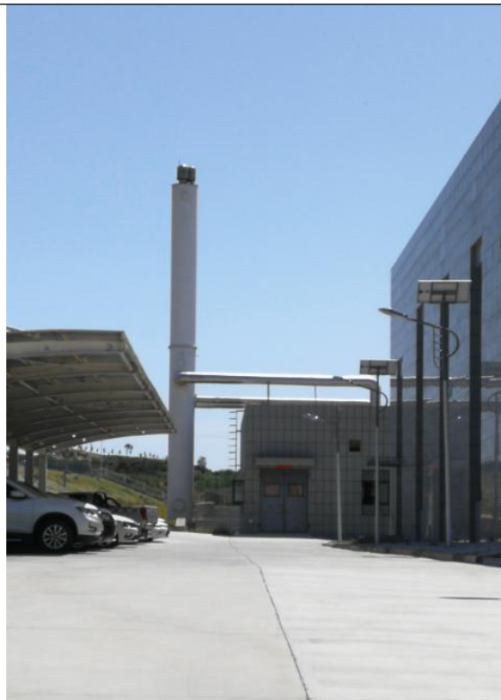
生活区燃气锅炉房集束排气筒
