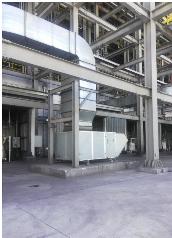
基础减震+隔声
