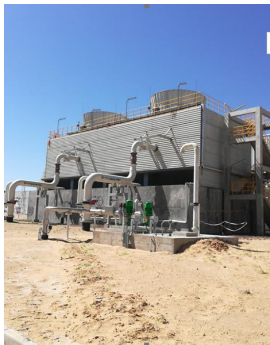
基础减震+隔声
